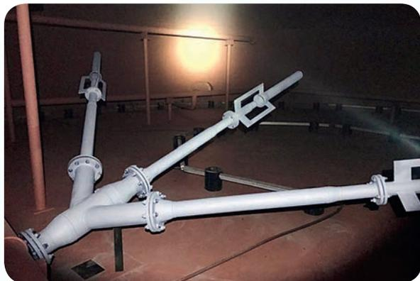
Струйный гидравлический смеситель с вихревыми устройствами
