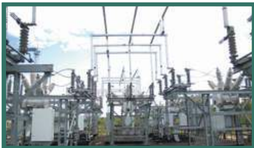
ОПЕРАТИВНО-ДИСПЕТЧЕРСКОЕ УПРАВЛЕНИЕ ЭЛЕКТРИЧЕСКИМИ СЕТЯМИ И ЭЛЕКТРООБОРУДОВАНИЕМ
