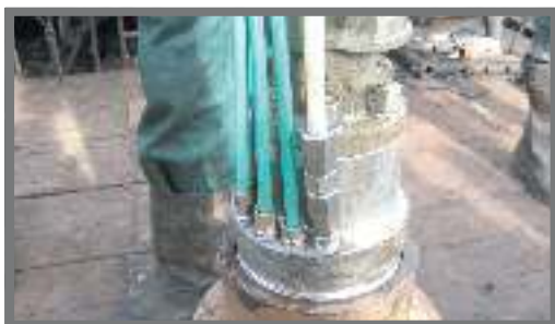
СПЕЦИАЛЬНЫЙ ПОЛИМЕРНЫЙ БРОНИРОВАННЫЙ ТРУБОПРОВОД (СПБТ)
