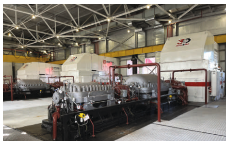
Газотурбинный привод ГТП-16ПА
